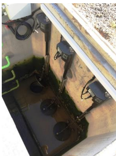
Clapetas en arqueta de repartición con apertura mediante actuadores
